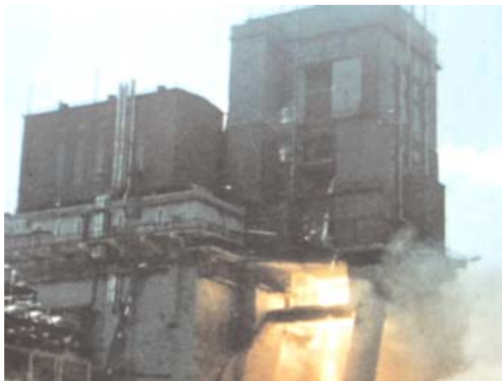
Рис. 2.36. Вертикальный стенд НИЦ РКП (испытание двигательной установки ступени РН тягой 11760 кН)
